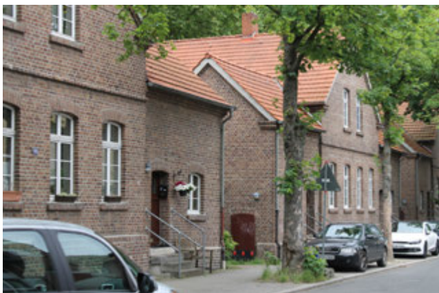
Abb.9: hochwertig sanierte Zehensiedlung in Buer
